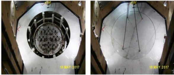
図 4 カバー構造の設置
