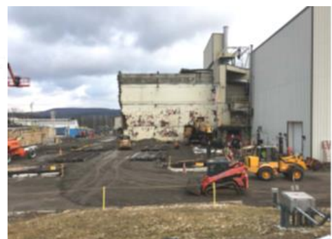
図3 解体中のプロセスセル外壁
