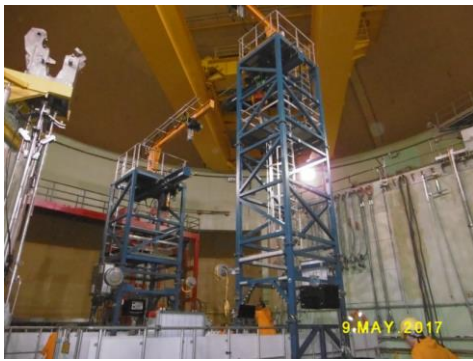
図 5 補助作業架台の設置
