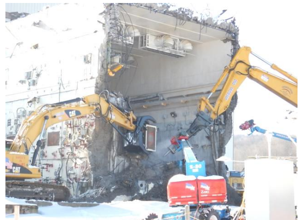
図 4 取り外される鉛ガラス遮蔽窓
