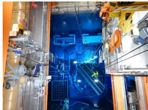
図 7 CRGT と SD の同時切断
